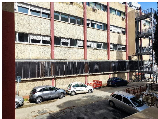
Figura 2 | Facciata ala Est
