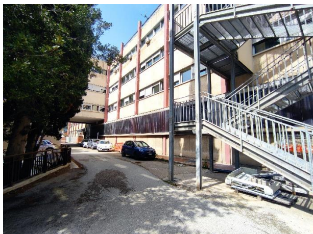
Figura 1 | Facciata ala Est
